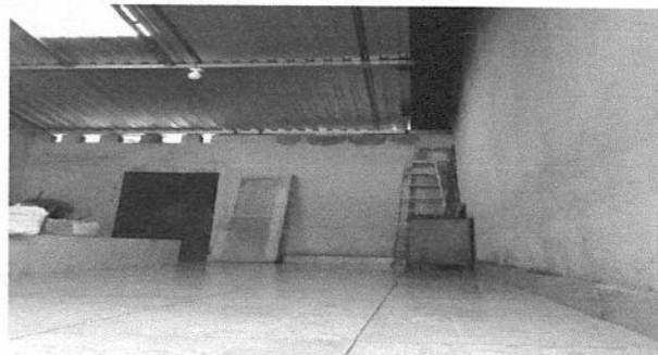
Foto 4: Cocina, Instalacion de piso ceramico en el area de la cocina.
