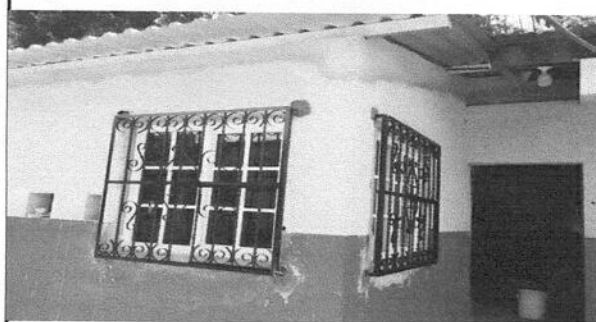
Foto 6: Cocina, Instalacion de ventas de metal mas vidrios.
